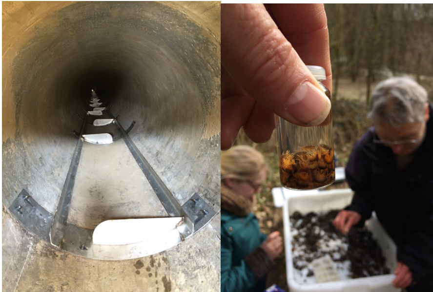
Durchlass in der Staumauer Husen; Analyse von Wasserinsekten. Fotos: U. Eichelmann
