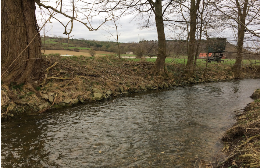
Wartet auf Befreiung: Verbauter Abschnitt zwischen Atteln und Henglarn. Foto: U. Eichelmann
